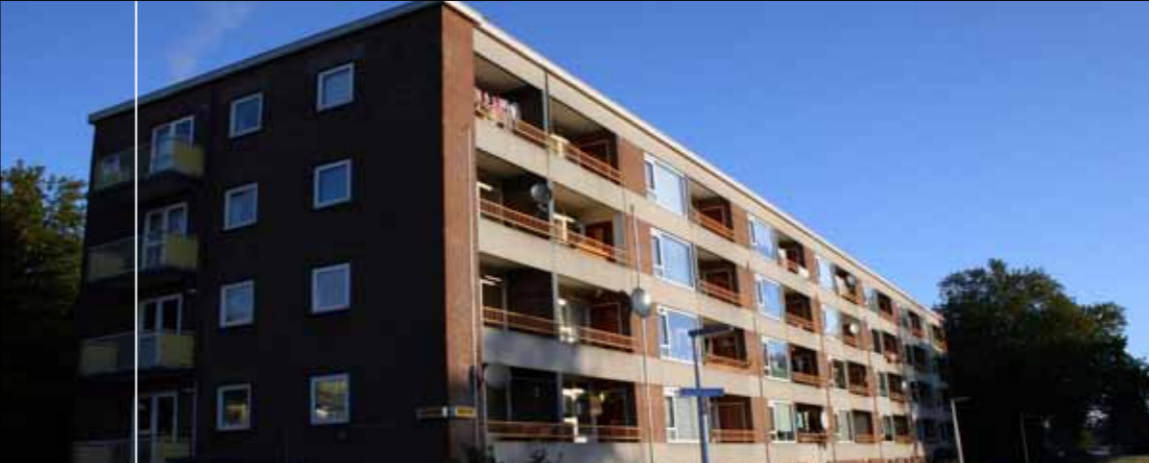
Een brand woedde in een appartement aan de Beethovenlaan. Vier woningen raakten beschadigd.
