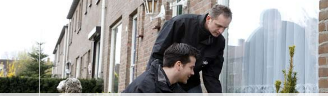
Edwin van der Kwast en collega Patrick van 't Sant (gehurkt) bij een Sité-woning op De Hoop, waarvan de ramen worden vervangen door kunstof exemplaren met hoogrendement dubbelglas.
