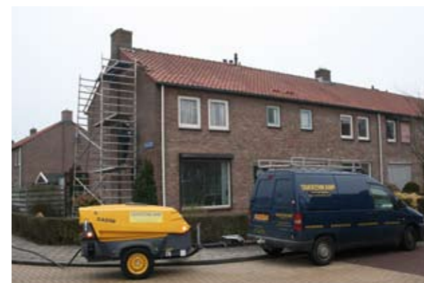
De firma Takkenkamp vervangt dit jaar alle slechte voegen aan de weerszijde van de woningen.
